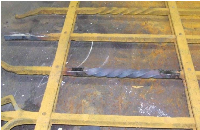
Figuur 17. Ingelast stuk getordeerde spijl.
